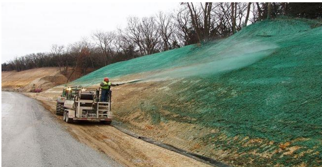
Figura 9. Hidrosiembra de un talud de carretera.
