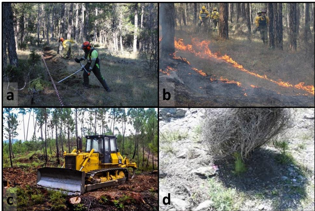
Figura 7. a) Eliminación de matorral con desbrozadora mecánica manual; b) Eliminación de matorral mediante quema controlada; c) Eliminación de matorral mediante maquinaria pesada; d) Facilitación ecológica entre matorral preexistente y planta repoblada.
