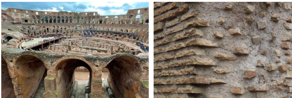
Figura 2. Opus caementicium usado para unir grandes piedras en el interior del coliseo [2].
