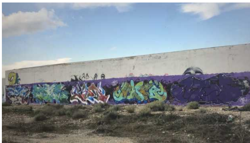
Fig. 30. Parque acuático Jaén, urbanización Valdeastillas. Exterior muro Edificio 1, Bloque morado. [Fuente: Sergio Cruz Molina]
