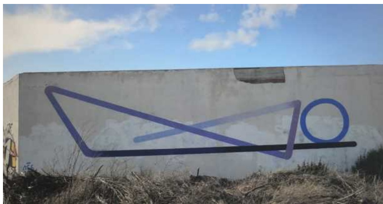
Fig. 34. Parque acuático Jaén, urbanización Valdeastillas. Exterior muro Edificio 1. [Fuente: Sergio Cruz Molina]
