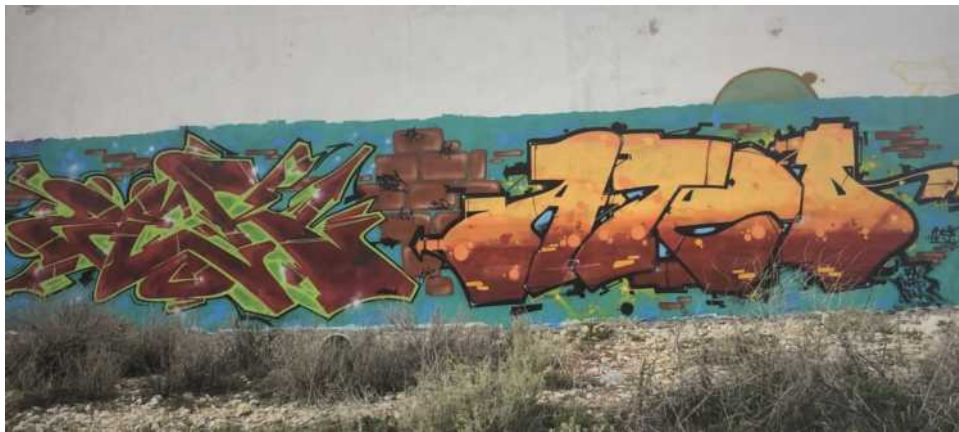
Fig. 31. Parque acuático Jaén, urbanización Valdeastillas. Exterior muro Edificio 1, Bloque verde. [Fuente: Sergio Cruz Molina]
