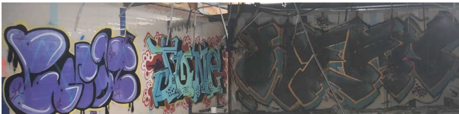
Fig. 42. Parque acuático Jaén, urbanización Valdeastillas. Interior habitación grande 2. [Fuente: Sergio Cruz Molina]
