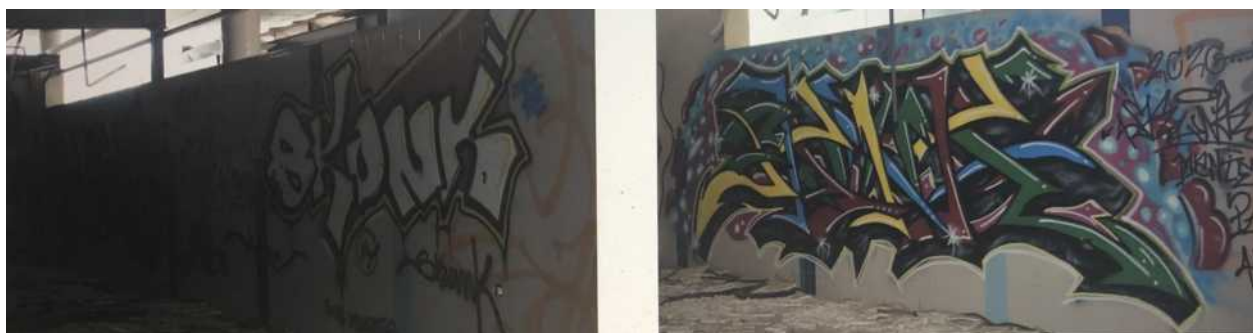
Fig. 43. Parque acuático Jaén, urbanización Valdeastillas. Interior habitación grande 2. [Fuente: Sergio Cruz Molina]
