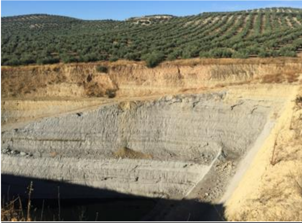
Fotografía 4. Detalle de talud final donde se aprecian las margas grises.
