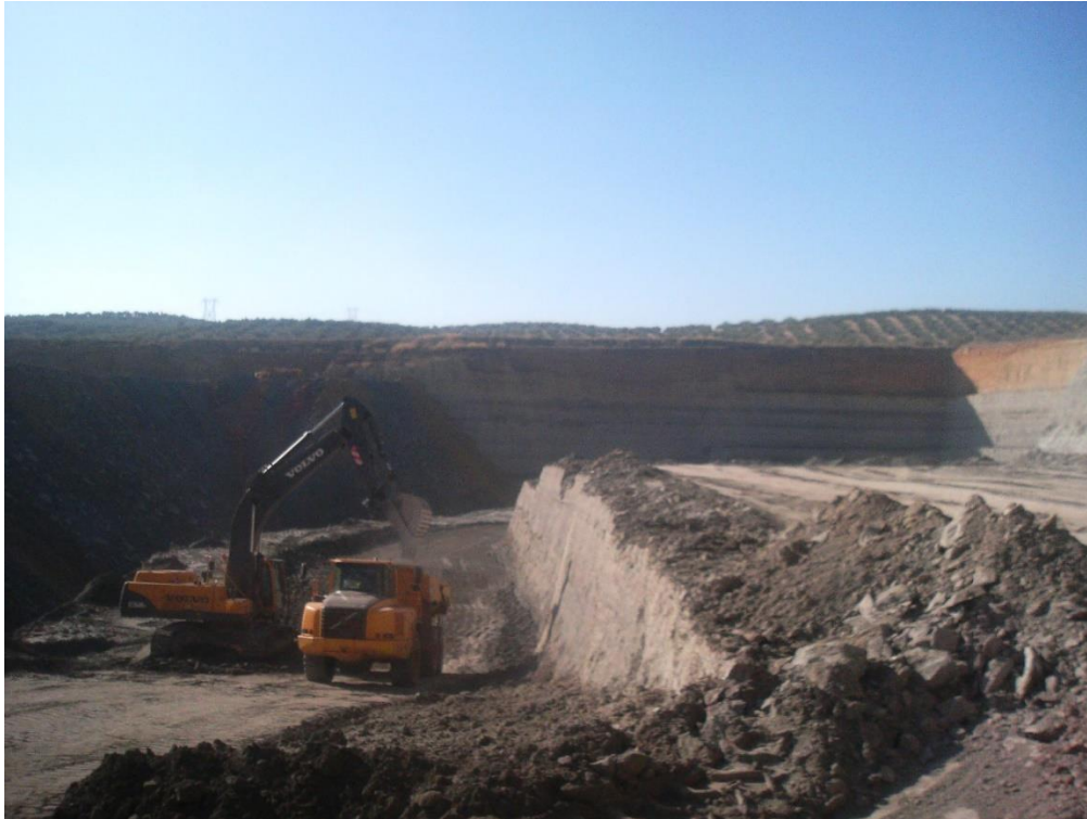
Fotografía 12. Carga de material mediante retroexcavadora y volquete.
