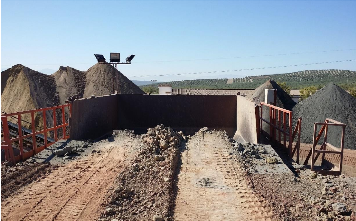
Fotografía 20 . Zona de descarga de la arcilla sobre la tolva.
