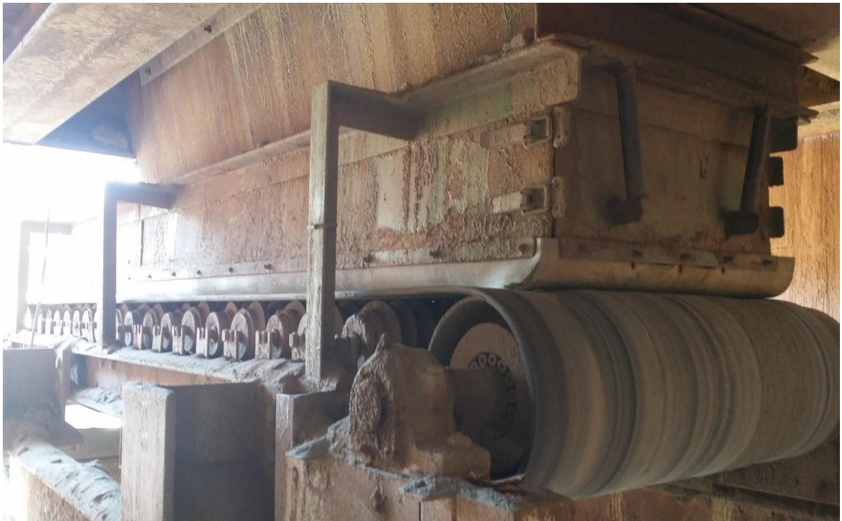
Fotografía 35 . Parte inferior del molino de rodillos
