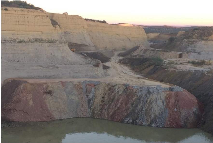
Fotografía 41. Frente en restauración.
