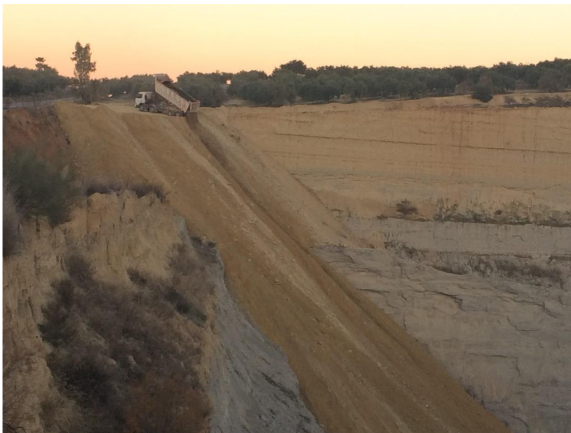
Fotografía 43. Frente en restauración.
