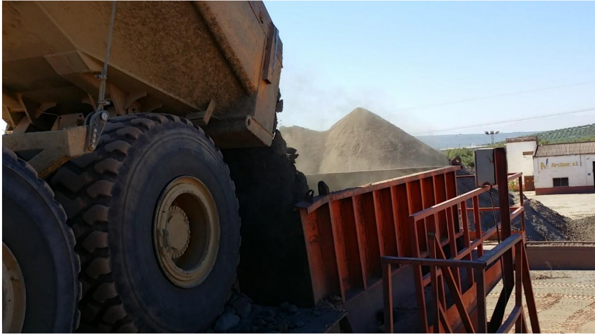
Fotografía 22. Dumper descargando la arcilla sobre la tolva.
