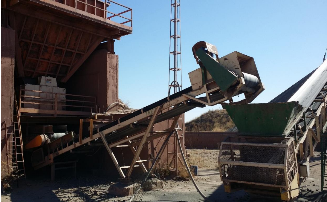
Fotografía 26. Transportador de banda
