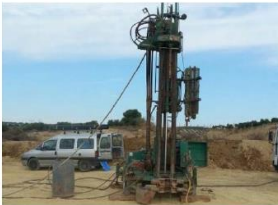
Fotografía 11. Trabajos para la ejecución del sondeo geotécnico
