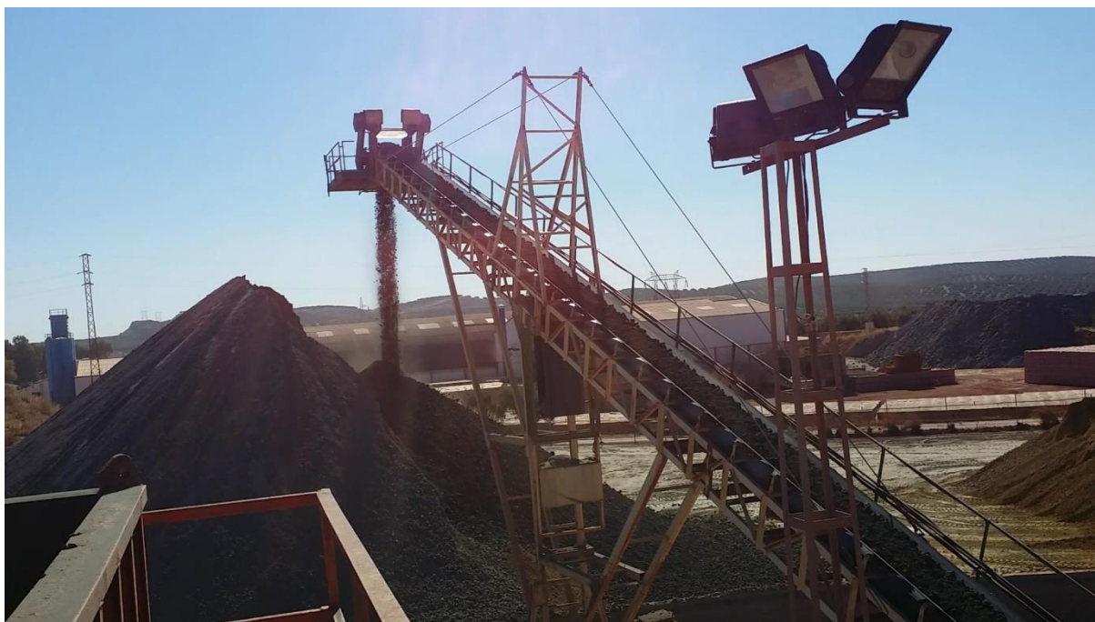
Fotografía 39 . Cinta transportadora depositando la arcilla en montones.
