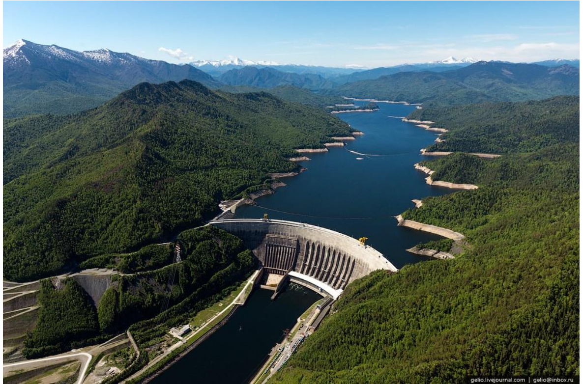
Figura 2.4 Central hidroeléctrica Sayano–Shúshenskaya
