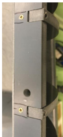
Figura 142. Uniones atornilladas en las costillas de la tobera.
