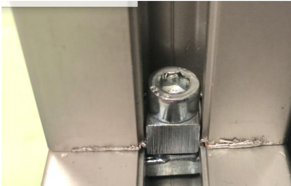
Figura 129. Unión atornillada de las barras.
