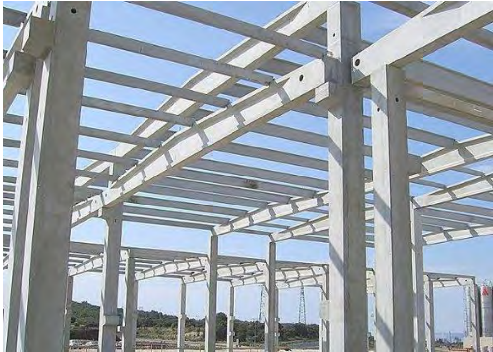
Figura 21. Estructura de hormigon pretensado.
