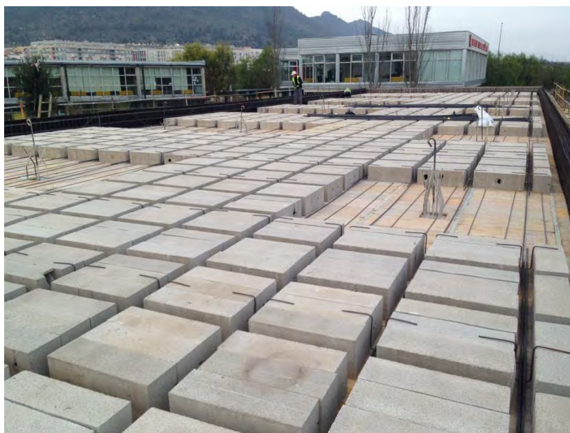
Figura 43. Imagen de forjado reticular con caseton de bloques perdidos.
