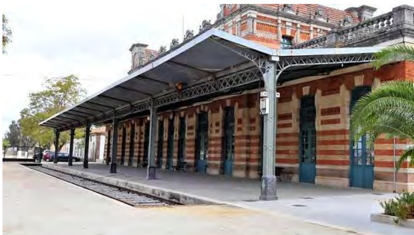
Figura 2. Antigua estacion Linares-Madrid. (ACTUALMENTE MUSEO)
