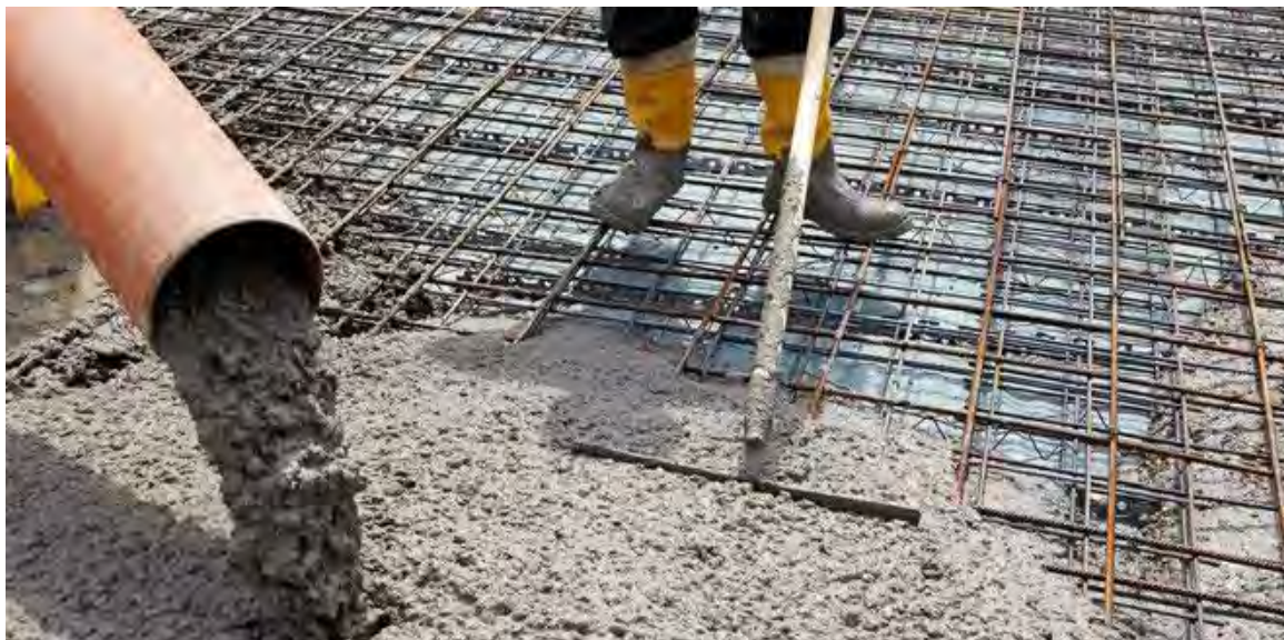
Figura 20. Vertido de hormigón en losa.
