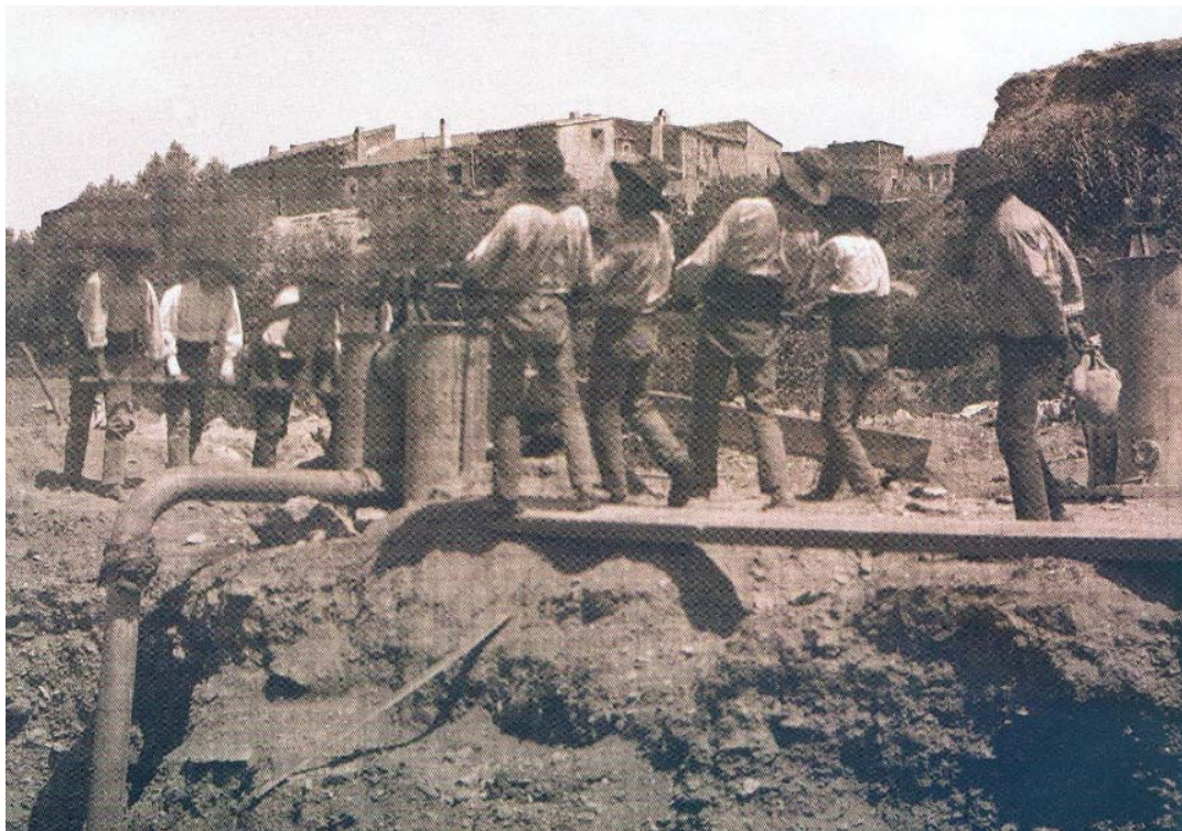
Fig. 42. La tecnología obsoleta, una bomba de agua a mano antes de la llegada de maquinaria cornish. Colección privada, 2017.
