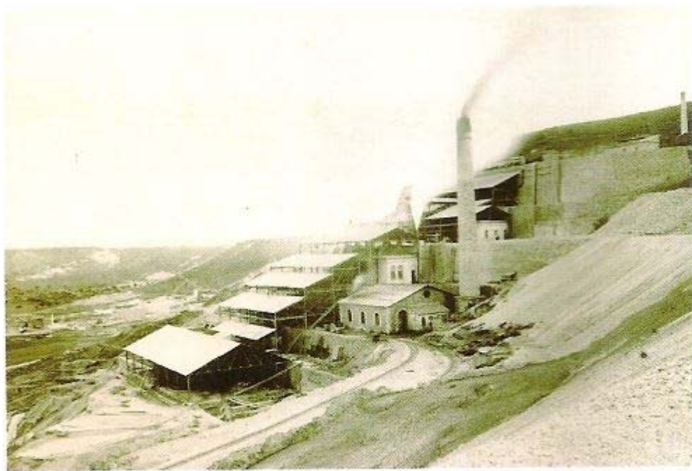
Fig. 31. Lavadero de Arrayanes, uno de los más eficientes de Europa (Proyecto Colectivo Arrayanes, 2013, pág. 9).
